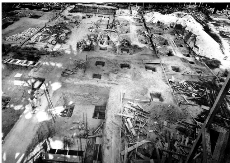
Figura 4 – Início das fundações do Sanatório de Belém (s.d.)
